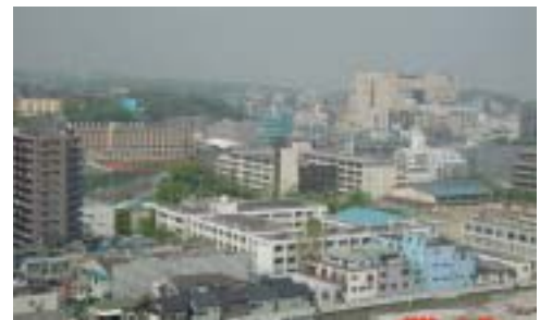
崩壊危険斜面や木造住宅密集地域も多い高津
