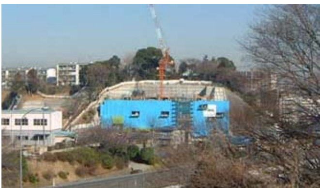
斜面地で進むマンション開発
